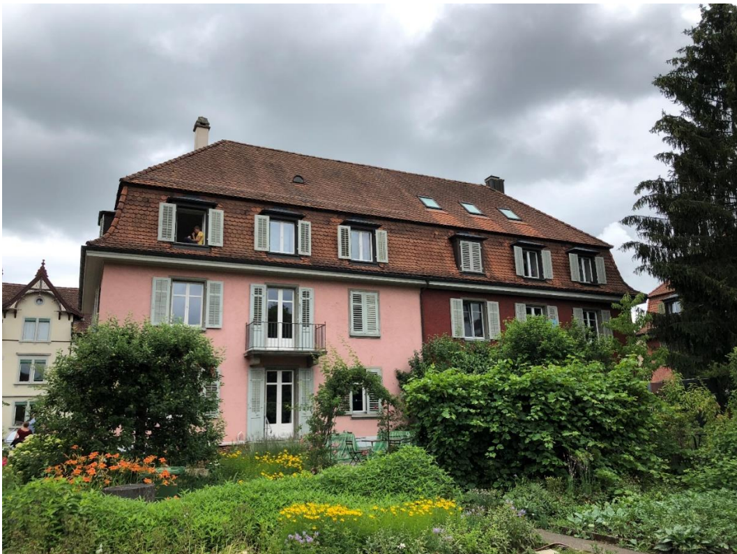
Abb. Ansicht Innenhof gegen Walkestrasse 12 und 14, Ansicht von Nordwesten
